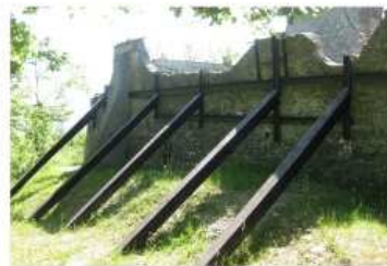
Cimitero di Casaglia. Sostegni a muro perimetrale
