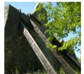
Cimitero di Casaglia. Sostegni a muro perimetrale
